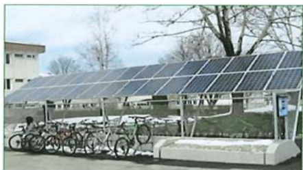
Figure 1. Exemple de réalisation abris vélos solaire, campus central de l'université de Strasbourg
